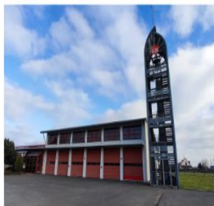
Caserne de Cléry St-André. C'est dans la tour que les tuyaux sont séchés. © Photo Blanche G.
